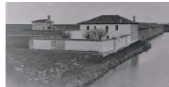
Casas del rey. Paredes de Nava. Fuente: J.L. de las Rivas.
